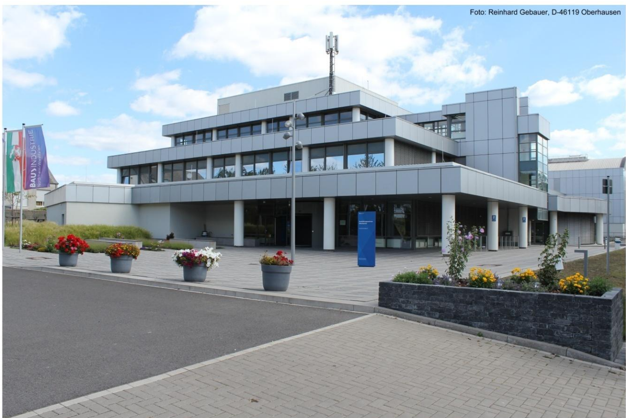
Ausbildungszentrum des Bauhandwerks NRW, Vestische Straße 46, D-46117 Oberhausen, 28.08.2022 (Spieellokal des Schachclubs Schwarze Dame Osterfeld)
